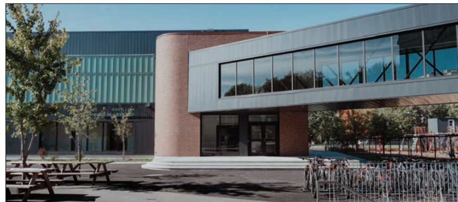
Adjacente au bâtiment principal et reliée par une passerelle offrant un accès direct à la cour arrière, cette nouvelle infrastructure représente un investissement de 6,1 M$.
